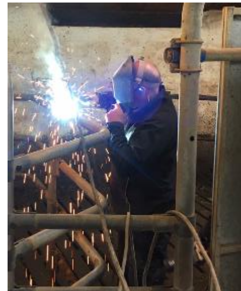
Svejsning giver den bedste forbindelse mellem inventardele og stålrammer
